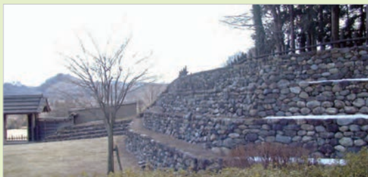
復元された石積土塁（いしつみどるい）。階段状に積み上げられている。
