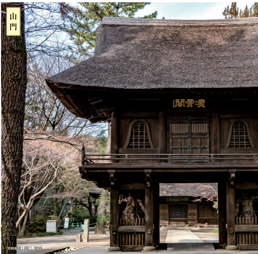
茅葺屋根が美しい、入母屋造りの山門です。平林寺が岩槻から移転した際に共に移築されました。堂々たるその姿は平林寺を代表する建築物です。（県指定有形文化財）
