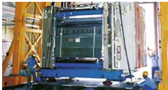
工場等に設置される大型の機械。運搬から据え付けまで行う
