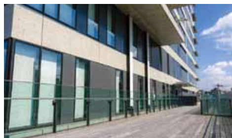
水害時、浸水高さ4mに対応できるベデストリアンデッキ
