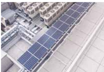
屋上に設置された太陽光発電パネル
