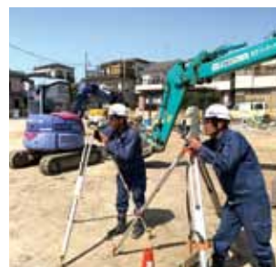
工事には正確な測量が欠かせない
