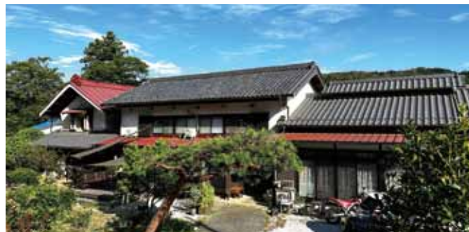
飯能市の郊外にある築100年余りの古民家が自宅兼オフィス
